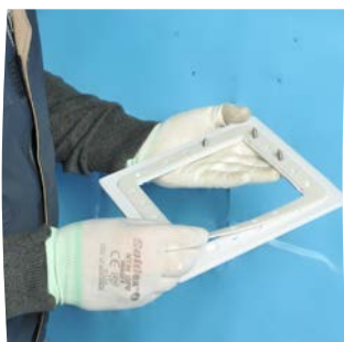
Coloque a junta sobre o flange
