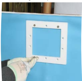
Avvitare il traversino e togliere il liner
