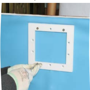
Aparafuse o flange e aligeire o liner
