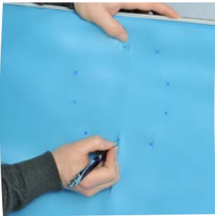
Localice y señale la ubicación de los tornillos
